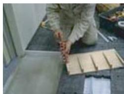
設置する間口にスロープスタンスが合わなければ丸ノコかノコギリで切断しておきます。切断したところに付属の脚を接着剤で取り付けます。スロープスタンスは両面テープまたは接着剤で床に固定します。写真は接着剤を使っています
