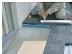
アルミ見切り材を両面テープか接着剤で床に固定します写真は接着剤を使っています
